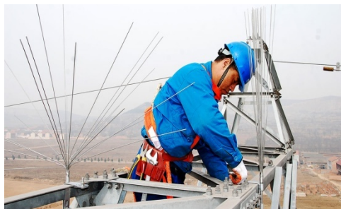
图2 金属驱鸟刺适合铁塔, 不适合双瓷横担水泥杆
