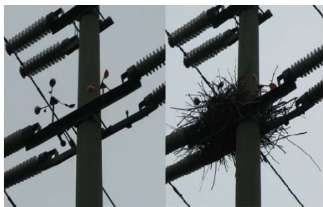
图1 小型风力驱鸟器失效后
